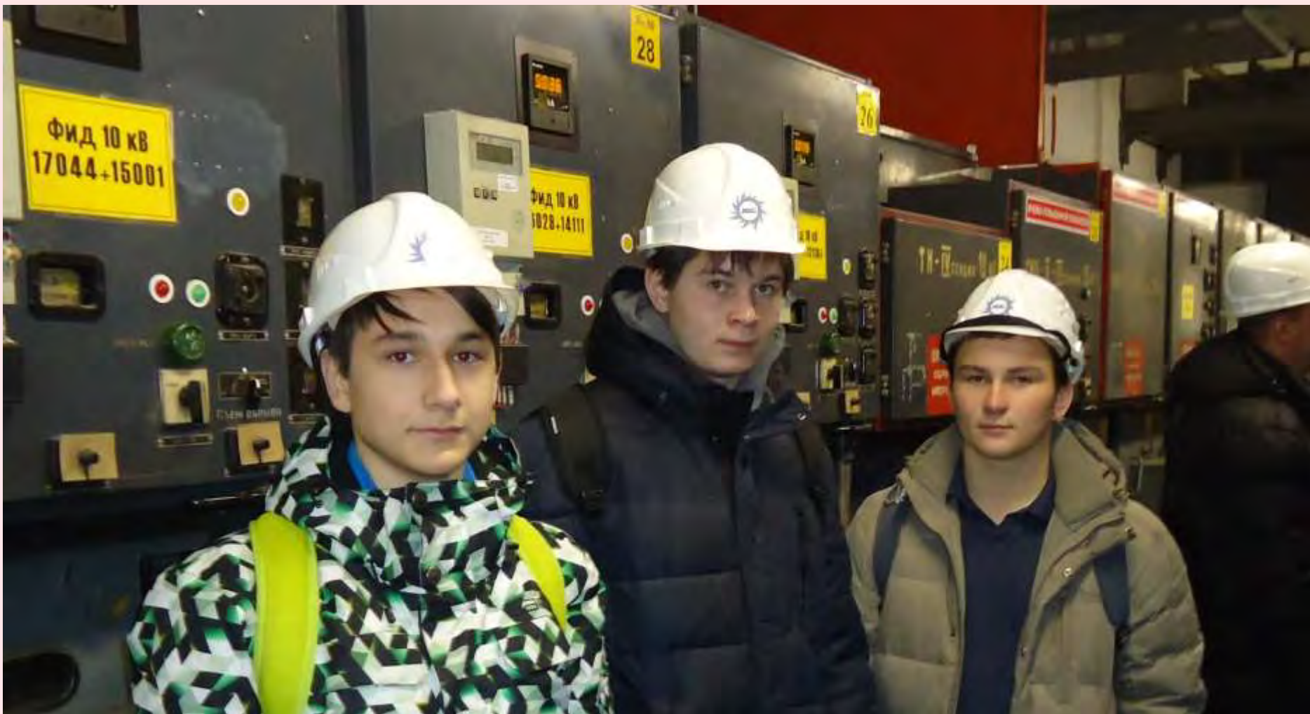
Экскурсия на высоковольтную подстанцию ПАО «МОЭСК
